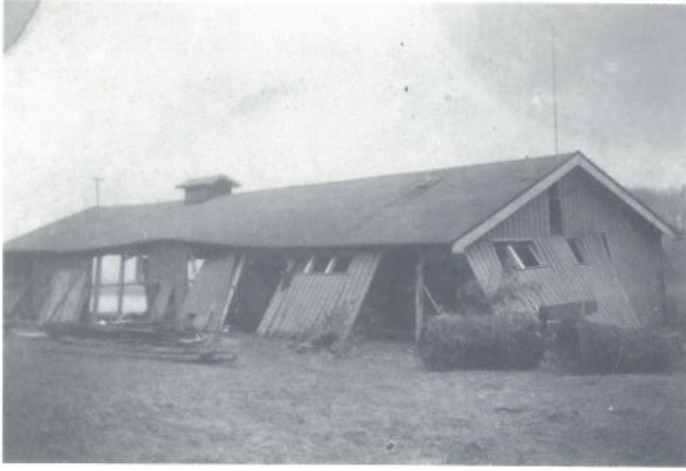
Das durch Hochwasser zerstörte Bootshaus des FRV 1887
